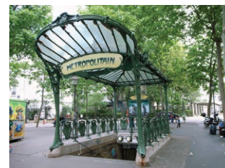
Entrada para o metrô de Paris, estação Abbesses. Hector Guimard, 1900-1912.
